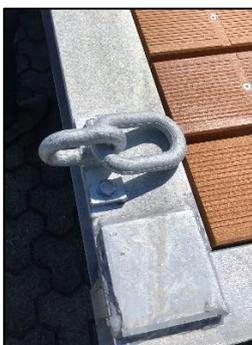
L'**ancoraggio** del palco avviene affrancando le catene individuate dalle boe dei corpi morti collocati sul fondale nel punto individuato per lo spettacolo ai ganci disposti ogni 1,5 metri sui 4 lati della piattaforma.
